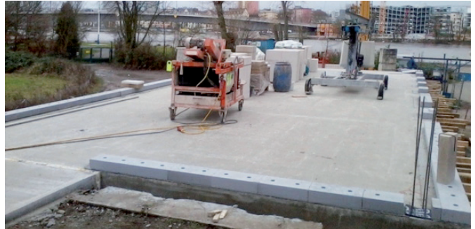
02.02. Die erste Steinreihe liegt auf der fertigen Decke
