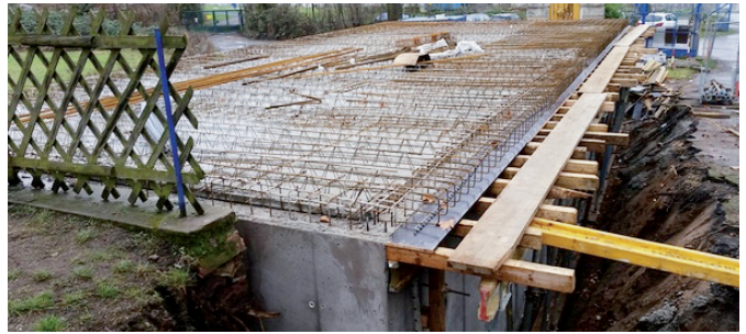
24.01.16 Die Zwischendecke ist montiert
