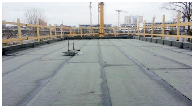
19.03. Das Dach ist abgedichtet
