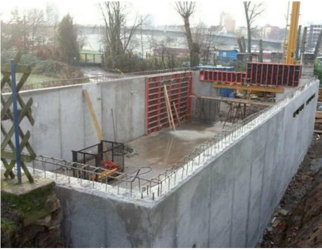
18.12. Das Bootslager ist fertig betoniert
