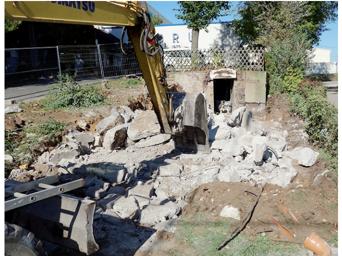
24.10.15 Abriss der alten Halle
