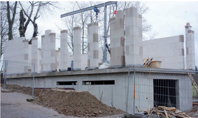
07.02. Es geht jetzt zügig voran
