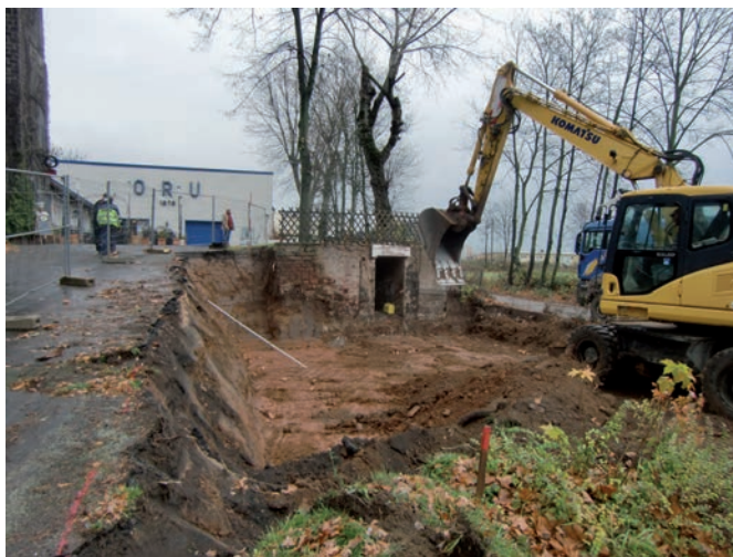
17.10. Die Fundamentfläche wird glatt gezogen ...
