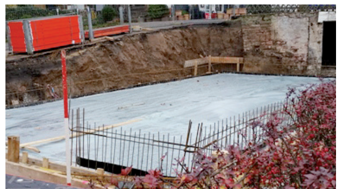
02.12. Das Fundament ist gegossen
