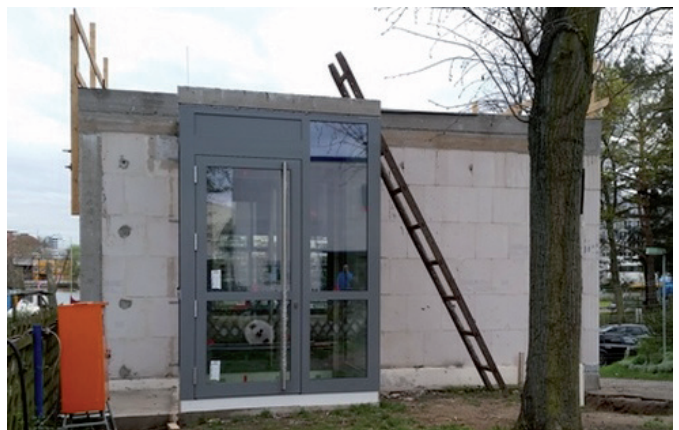
13.04. Die Fenster und der Eingangsbereich sind montiert
