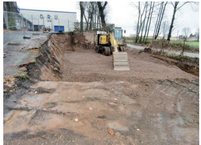
... und ein Schotterbett wird eingebracht
